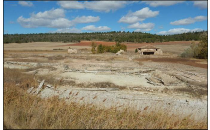
Detalle del estado actual de las instalaciones de la salina, con la balsa de decantación y las balsas de evaporación parcialmente destruidas.
